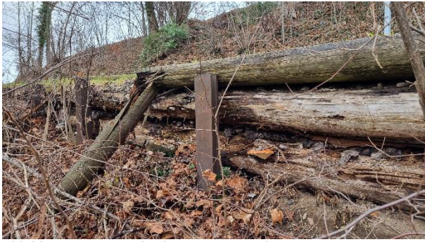
Abbildung 4: Zustand talseitige Hangsicherung
